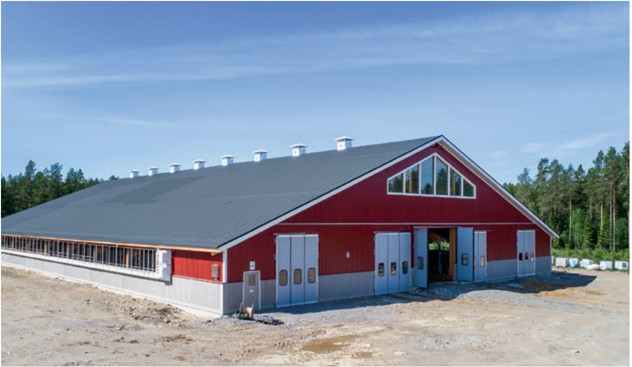
LANTBRUKSBYGGNAD ÅBYN Mjölkkorna på Brännfors Lantbruk några mil norr om Skellefteå har gott om utrymme i den nya lantbruksbyggnaden på 35 x 60 meter.
